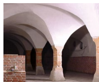
Notranji zidovi teh stavb so sanirani s KÖSTER Sanirnim ometom v beli barvi.
