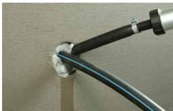
Затем пистолетом нагнетается KÖSTER KB-Flex.
