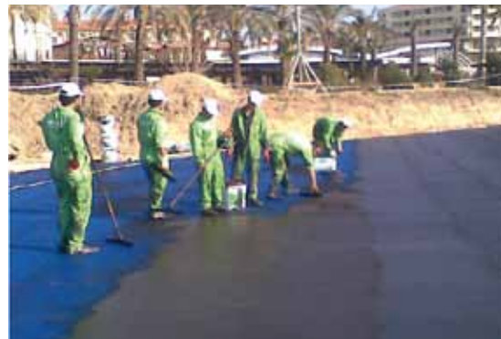
Гидроизоляция с KÖSTER Deuxan®.
