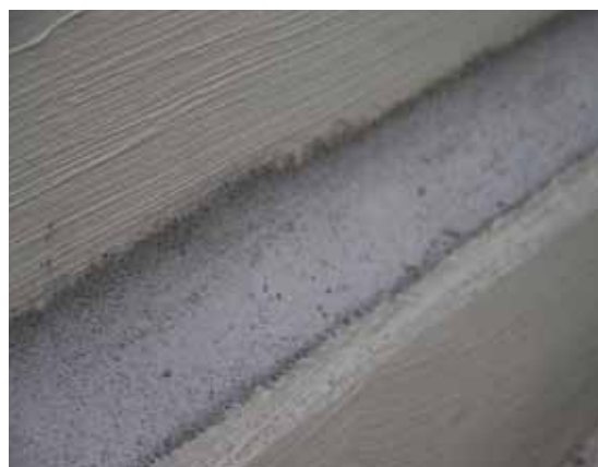
Закругленная галтель из раствора KÖSTER Repair Mortar
