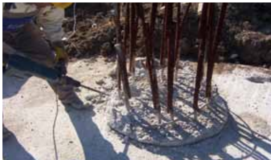
Удаление выступов и очистка оголовка сваи
