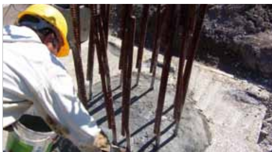
Нанесение KÖSTER NB 1 Grey
