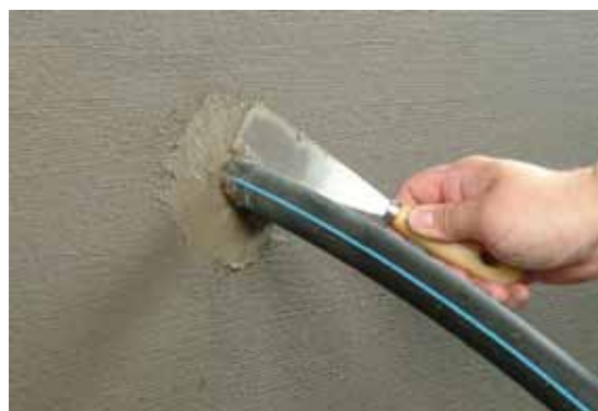
В качестве защитного слоя наносится KÖSTER KB-Fix 5.
