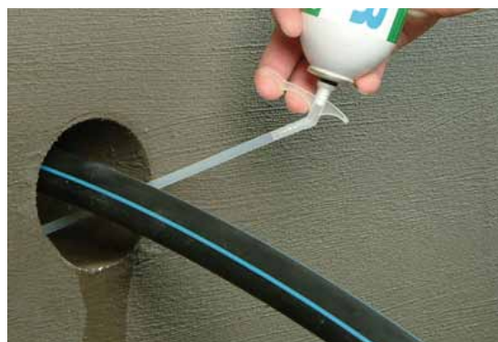
Сначала вводится монтажная пена в качестве наружной опалубки для KÖSTER KB-Flex 200.
