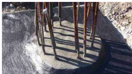
Подведение поверхностной гидроизоляции (KÖSTER Deixan®) к гидроизоляции оголовка сваи
