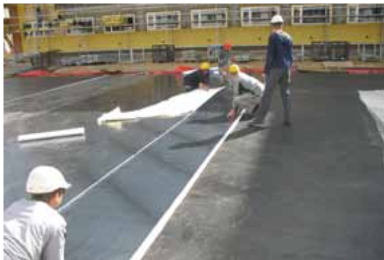
Гидроизоляция мембранами KÖSTER KSK
