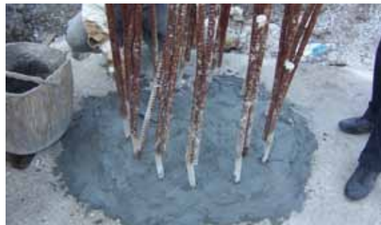
Установка галтели и выравнивание поверхности ремонтным раствором KÖSTER Repair Mortar.
