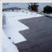
Uszczelnianie istniejących warstw bitumicznych
