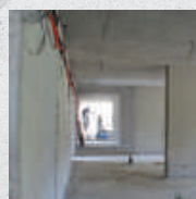
Wielkopowierzchniowe naprawy i renowacje
