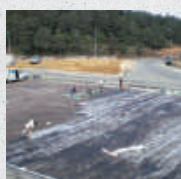
Hydroizolacja płyt fundamentowych
