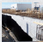
Hydroizolacja podziemi po stronie zewnętrznej
