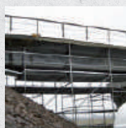
Naprawy konstrukcji mostowych
