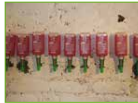
Selv installasjon av horisontal tetning
