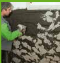
Det mates ut et lag av materiale, for å sikre optimal vedheft
