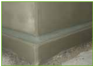
Forbehandling av underlaget
