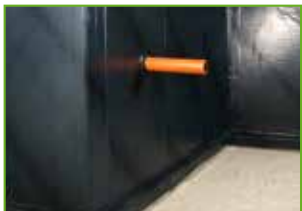
Tetningen er installert.
