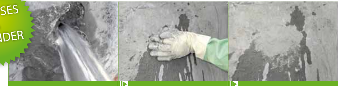
En aktiv lækage forsegles øjeblikkeligt efter påføring af Kældertæt 2 Blitzpulver.
