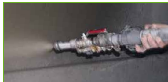
NB Tætningssvumme I grå kan enten påføres med en børste eller den kan sprøjtes på overfladen, for eksempel med KÖSTER Variojet FU-KB Snekekumpe.
