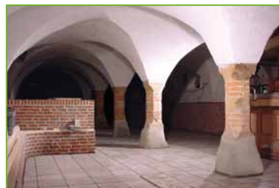
De indre vægge i disse bygninger blev renoveret med KÖSTER Saneringspuds II hvid.
