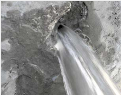
Una fuga activa se sella al instante tras aplicarla KÖSTER KD 2 Blitz Powder.
