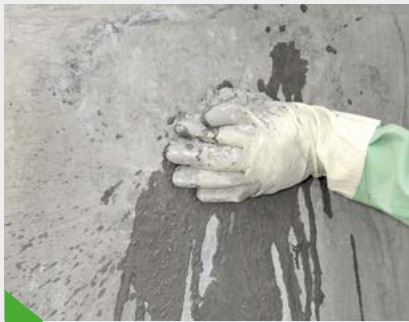
Una fuga activa se sella al instante tras aplicarla KÖSTER KD 2 Blitz Powder.
