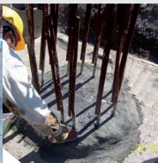
Impermeabilización de la cabeza del pilote con KÖSTER NB 1 Gris.
