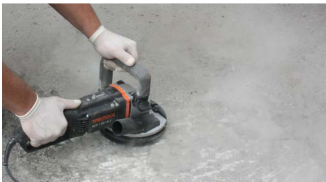
Preparación del sustrato
