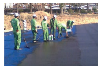
Impermeabilización con KÖSTER Deuxan 2C
