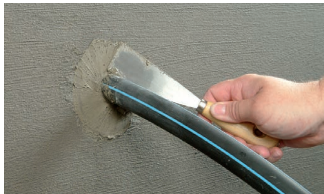
Para proteger la impermeabilización y proporcionar soporte mecánico, el área alrededor de la tubería o el cable se tapa con KÖSTER KB-Fix 5.
