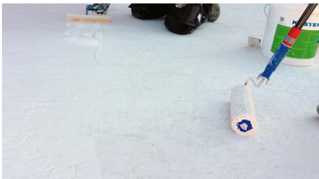
Aplicación de la segunda capa de KÖSTER 21
