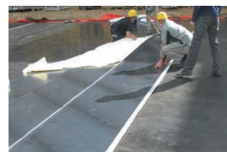
Impermeabilización con KÖSTER KSK
