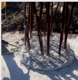
Eliminación de protuberancias, limpieza de la cabeza del montón.
