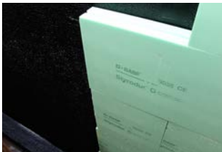
Los paneles aislantes se pueden fijar fácilmente con dos componentes. KÖSTER PMBCs. Es importante que los paneles aislantes estén completamente adheridos.
