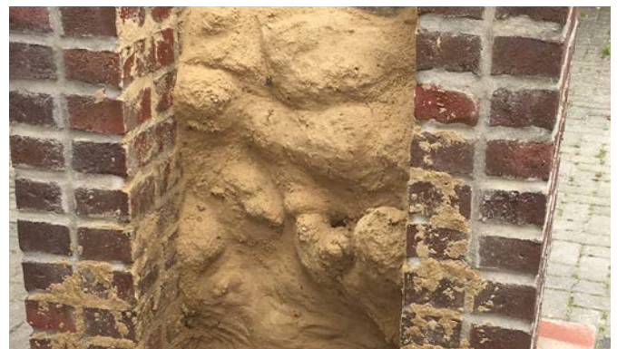
Inyección de cortina (vista trasera)
