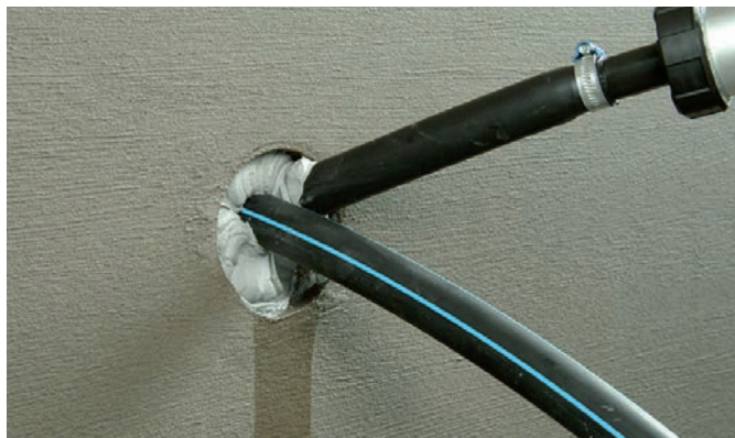
KÖSTER KB-Flex 200 se instala en el hueco utilizando el KÖSTER Special Caulking Gun.
