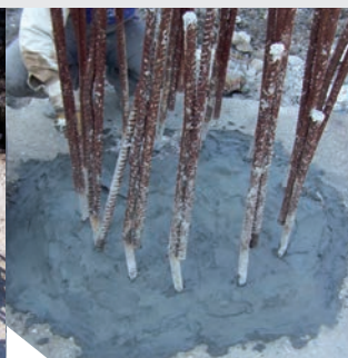
Instalación de un filete y alisado de la zona con KÖSTER R4 Mortar.
