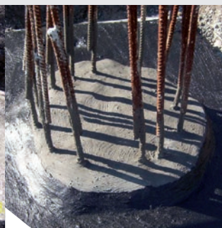
Conexión de la impermeabilización de la zona (KÖSTER Deuxan 2C) con la impermeabilización de la cabeza del pilote.
