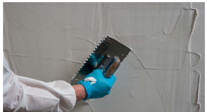
Primera capa de KÖSTER 21 con KÖSTER Flex Fabric
