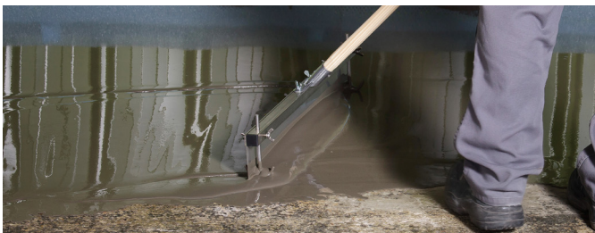
5 En áreas grandes, utilizar un rastrillo nivelador KÖSTER para distribuir el material
