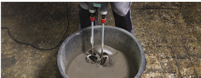
3 Mezclar intensamente durante tres minutos utilizando una mezcladora eléctrica de palas
