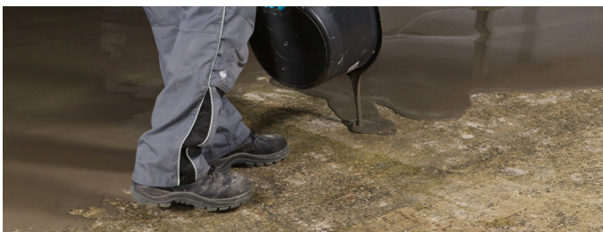
4 Distribuir el material con el espesor deseado de capa directamente después del mezclado
