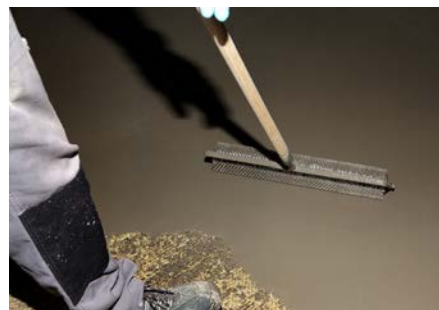
6 Por último, utilizar un rodillo de púas KÖSTER para desairear
