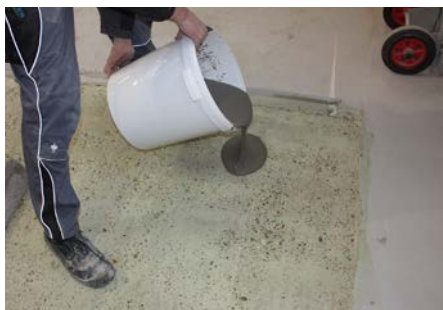
4 Distribuir el material con el espesor deseado de capa directamente después del mezclado
