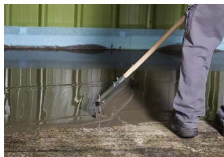
5 En áreas grandes, utilizar un rastrillo nivelador KÖSTER para distribuir el material
