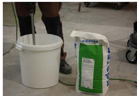
3 Utilizar una batidora de palas eléctrica y mezclar intensamente durante tres minutos
