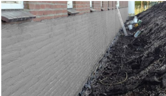
Impermeabilización externa de sótanos
