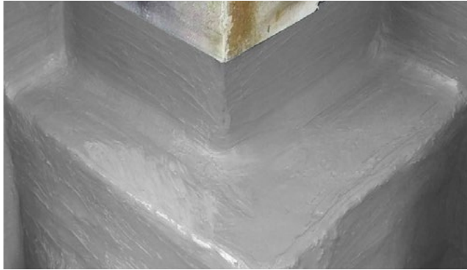
Zócalo de cimentación
