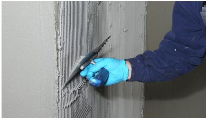
Impermeabilización interna de sótanos
