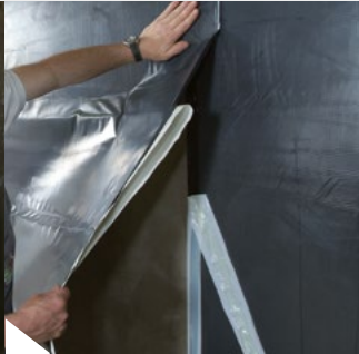
Aplicación de la membrana
