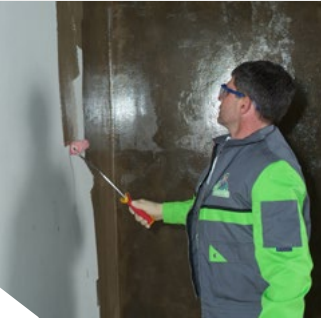
Imprimación del soporte
