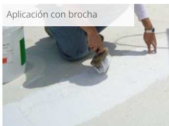
4 KÖSTER Superfleece se aplica sobre la primera capa fresca.
