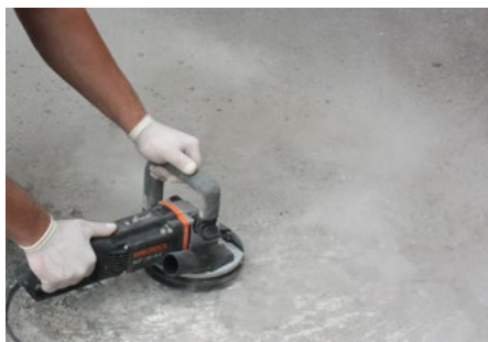
1 Preparación del sustrato
