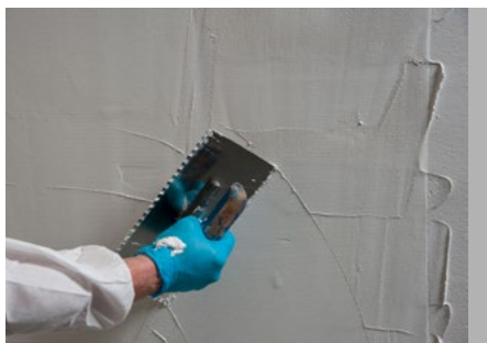
4 KÖSTER Superfleece se aplica sobre la primera capa fresca.
