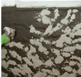
Aplicación de una capa de agarre fabricada con revoque de restauración KÖSTER.
