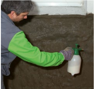
Imprimación con KÖSTER Polysil TG 500
