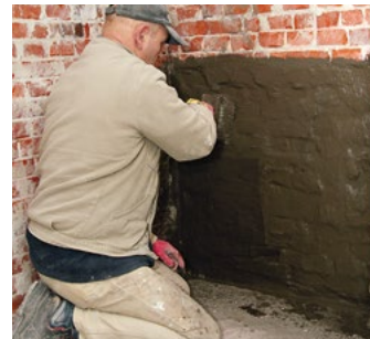
4 KÖSTER KD 1 Base: en 2 capas (segunda capa después de 30 minutos)
