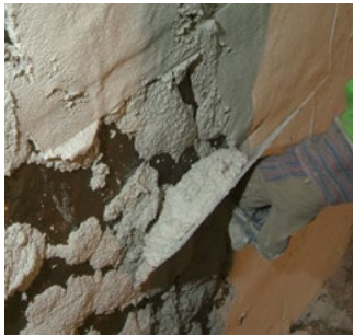
Aplicación del revoque de restauración KÖSTER
