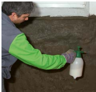
Imprimación con KÖSTER Polysil TG 500
