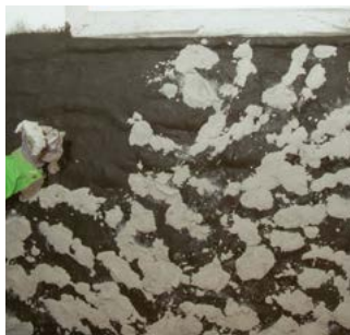
Aplicación de una llave de yeso fabricada con yeso de restauración KÖSTER.
