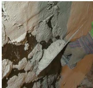
Aplicación del yeso de restauración KÖSTER
