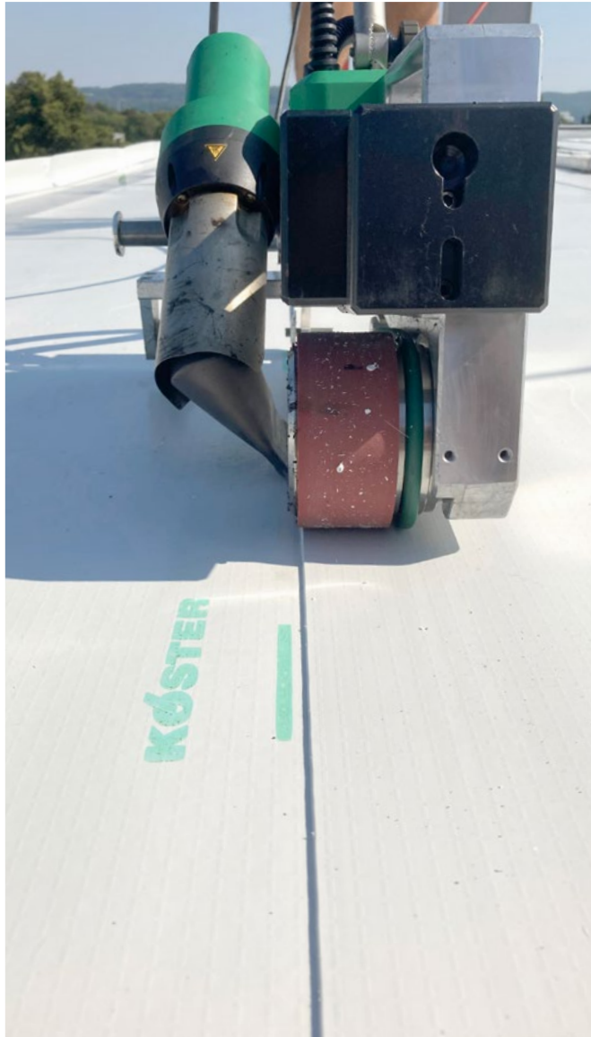
Procesamiento mediante soldadura por aire caliente
