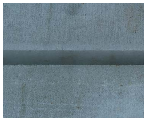
Flancos de las juntas limpios
