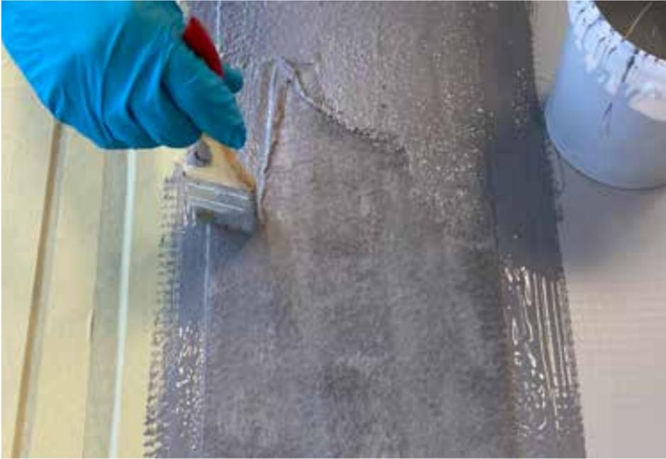
Anschließend wird „nass in nass“ die zweite Lage aufgetragen. Es ist eine Gesamtschichtdicke von mindestens 2,1 mm inkl. Verstärkungslage herzustellen.
