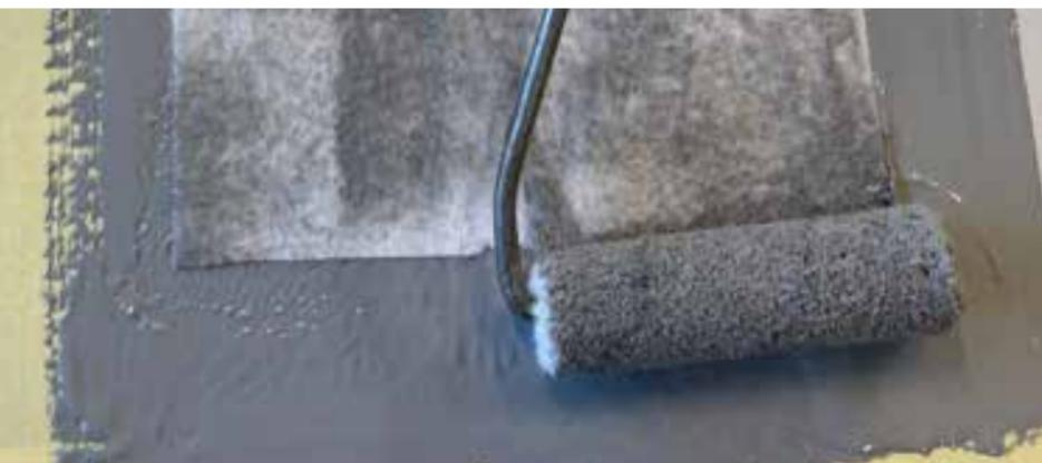
In die feuchte MS-Flexfolie wird sofort falten- und blasenfrei KÖSTER Superfleece eingelegt und mittels Walze angedrückt.
