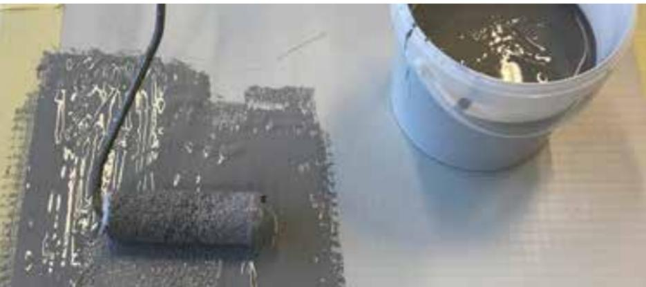
Die erste Schicht wird mit Hilfe eines Pinsels, einer Walze oder einer Zahnkelle verarbeitet.
