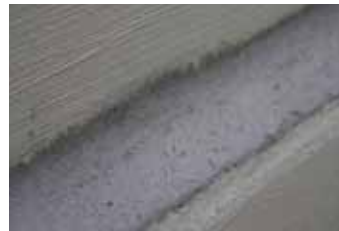
2. Hohlkehle mit KÖSTER Sperrmörtel
