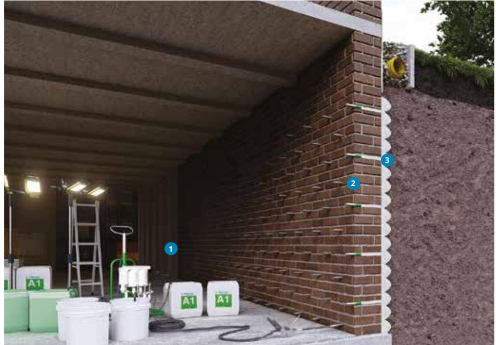
Kelleraußenabdichtung von Innen? Im Instandsetzungsfall ist es nicht immer möglich, die Kelleraußenwände freizulegen, z. B. weil die freizulegende Fläche überbaut oder aus anderen Gründen nicht zugänglich ist. Hier wäre zunächst an eine Innenabdichtung (Negativabdichtung) zu denken. Doch in einigen Fällen, z. B. bei historischen Bauwerken oder bei besonderen architektonischen Anforderungen, kommt auch dies nicht in Frage.
