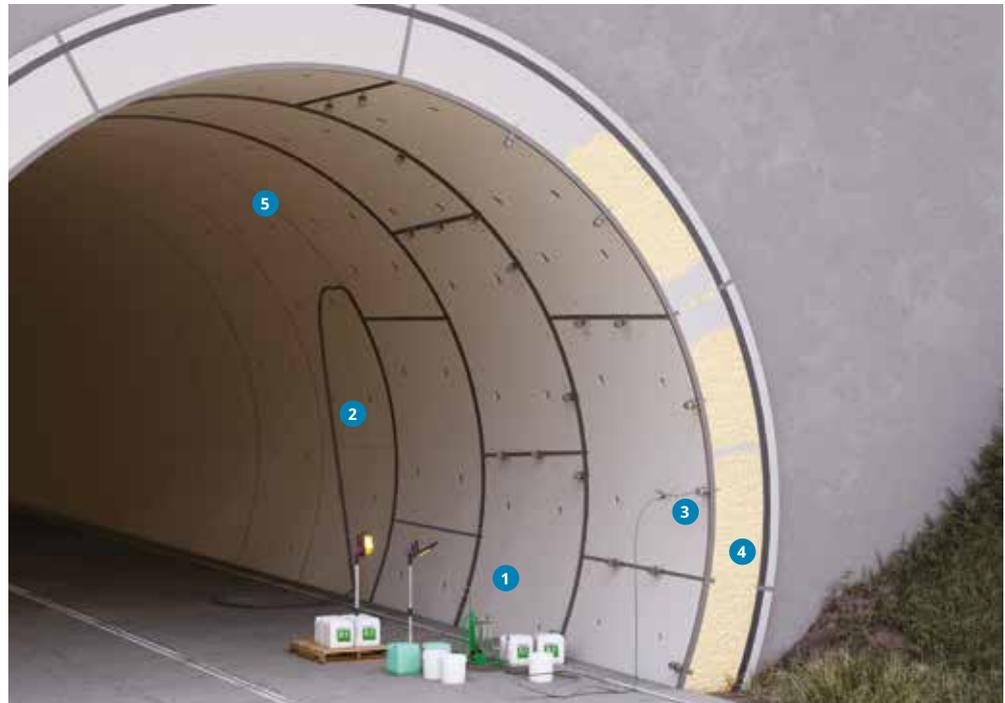
Der komplexe Tunnelbau bringt große Herausforderungen an das Abdichtungssystem mit sich. Auch bei höchsten Standards kann es besondere Situationen oder außergewöhnliche Konditionen geben, die zu Undichtigkeiten in den Tunneln führen können. Diese Undichtigkeiten befinden sich meist entlang der Fugen zwischen den Tübbingelementen. Bleiben diese feuchten Stellen unbehandelt, kann es zu schweren Schäden kommen, die die strukturelle Integrität des Tunnels beeinträchtigen können.
