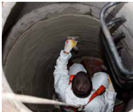
Aufziehen des Mörtels mit einer Kelle auf den feuchten Untergrund
