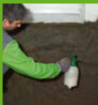
Grundieren mit KÖSTER Polysil® TG 500
