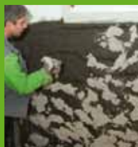
Aufbringen des KÖSTER Spritzbewurfs
