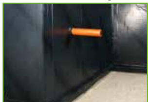
Die Abdichtung ist installiert.
