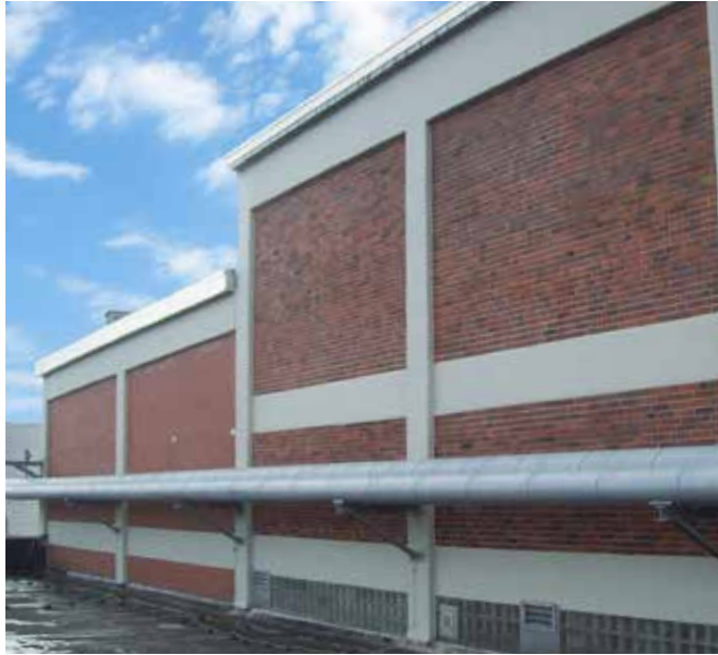
Melitta in Minden, Deutschland: nach Betoninstandsetzung und Fassadenschutz
