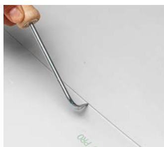
Nahtkontrolle mit Prüfnadel
