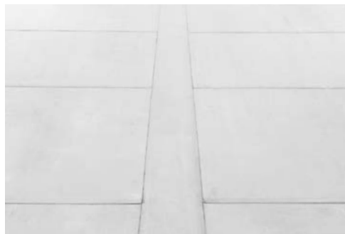
Aufgebrachter TPO-Streifen über längere Distanz
