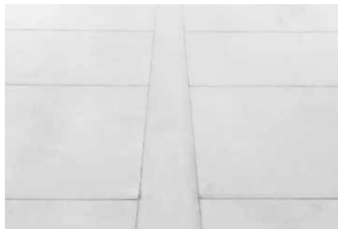
Aufgebrachter TPO-Streifen über längere Distanz
