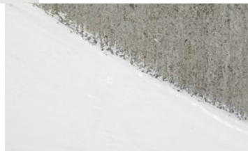
KÖSTER MF 1 in zwei Schichten kreuzweise auftragen.
