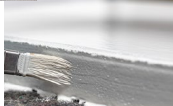
KÖSTER MF 1 in zwei Schichten kreuzweise auftragen.
