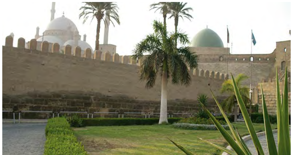
Ein Beispiel für aufsteigende Feuchtigkeit
