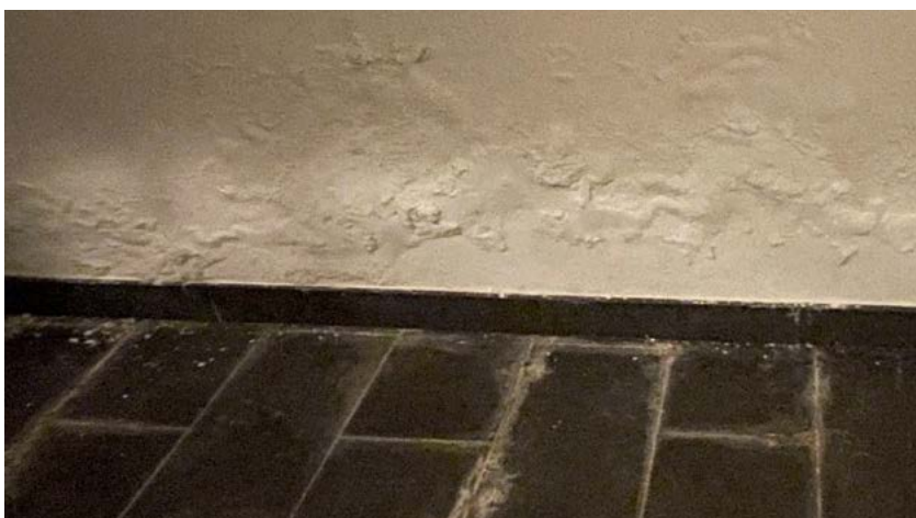
Typische Schadensbilder aufsteigender Feuchtigkeit
