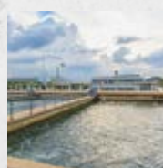
Auffang- und Vorratsbecken
