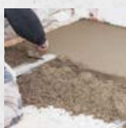
Zur Herstellung von Estrich
