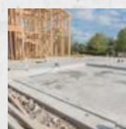
Wand- und Bodenplatten
