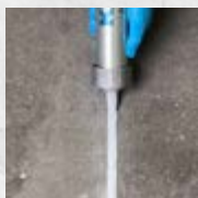
Dehnungsfugen im Estrich
