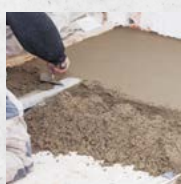
Zur Herstellung von Estrich
