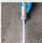
Dehnungsfugen im Estrich
