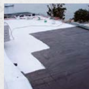
Abdichtung auf Bitumen
