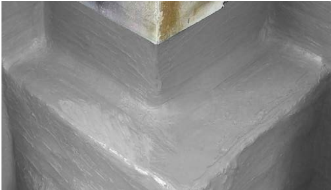
Fuß- und Sockelabdichtung
