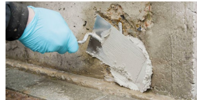
4 KÖSTER Betomor Multi A wird mit Spachtel oder Traufel in einem Arbeitsgang aufgezogen.
