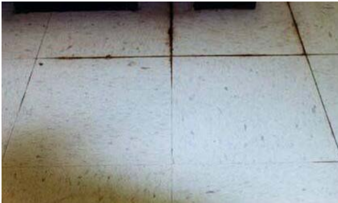
Feuchtigkeit und hoher pH-Wert lösen Kleber auf...
