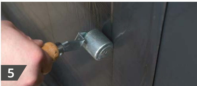
Die Bahnen ganzflächig anrollen und insbesondere die Überlappungen fest zusammenpressen.
