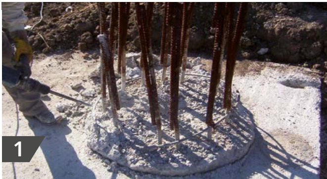
1 Entfernen von überstehendem Beton und Reinigung der Oberfläche
