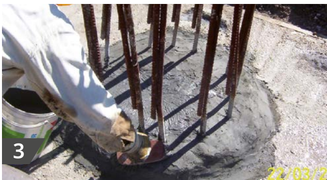
3 Abdichtung des Pfahlkopfes mit KÖSTER NB 1 grau
