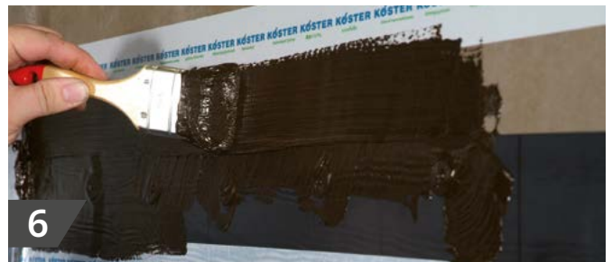
Die obere Bahnensicherung erfolgt mit Großkopfnägeln. Anschließend werden die Ränder der Abdichtung mit KÖSTER KBE-Flüssigfolie abgespachtelt.
