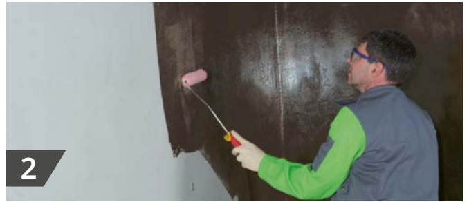
Grundierung der Oberfläche mit KÖSTER KBE-Flüssigfolie.
