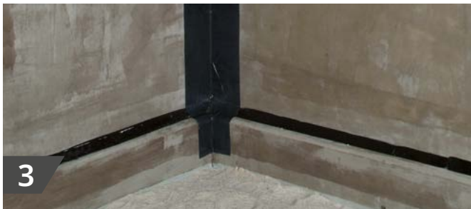
Anschließend werden die äußeren und inneren Ecken abgedichtet.
