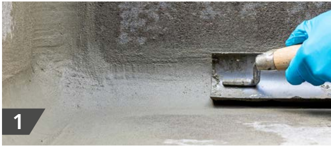
Für Hohlkehlen eignet sich KÖSTER Sperrmörtel WU.
