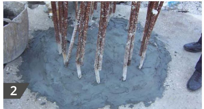
2 Ausgleichen und Einebnen der Oberfläche mit KÖSTER Sperrmörtel WU
