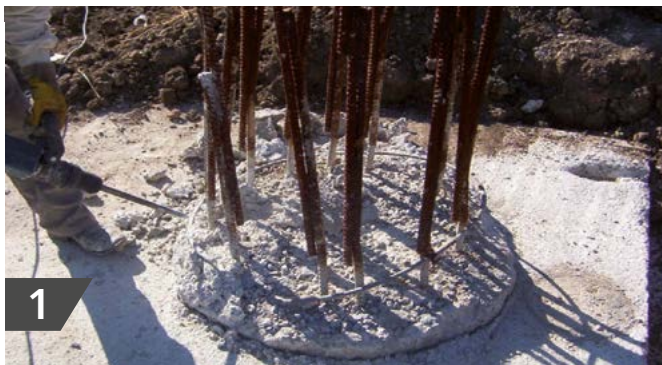
Entfernen von überstehendem Beton und Reinigung der Oberfläche
