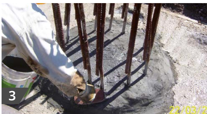
Abdichtung des Pfahlkopfes mit KÖSTER NB 1 grau
