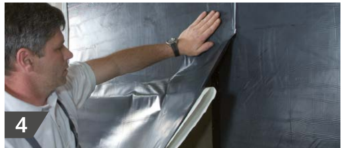
Die KSK-Bahnen auf der Fläche so anordnen, dass die Ränder mindestens 10 cm überlappen.
