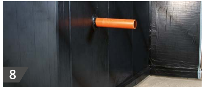
Die untere Bahnensicherung erfolgt ebenfalls durch Abspachtelung mit KÖSTER KBE-Flüssigfolie.
