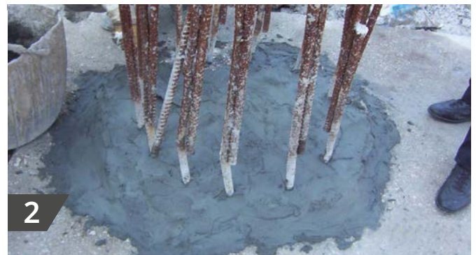
Ausgleichen und Einebnen der Oberfläche mit KÖSTER Sperrmörtel WU
