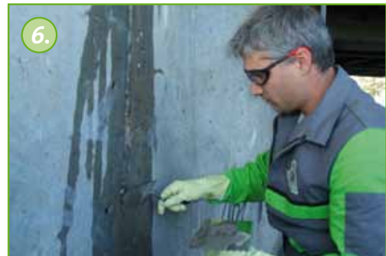
Anschließend kann der Riss z. B. mit KÖSTER KB-Fix 5 geschlossen werden. Das Verschließen des Risses verhindert, dass Injektionsmaterial vorzeitig während der Injektion aus dem Riss herausfließt. Die Verarbeitungszeit beträgt circa 5 Minuten, abhängig von der Umgebungstemperatur und der Luftfeuchtigkeit.
