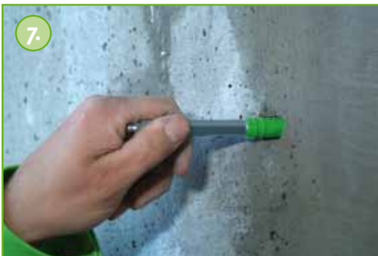
Jetzt werden die KÖSTER Superpacker in die Bohrlöcher eingesetzt, wobei etwa jedes dritte Bohrloch zunächst offen bleibt.
