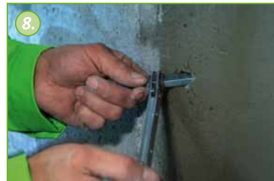
Die Packer werden mit einem Schraubenschlüssel festgezogen.
