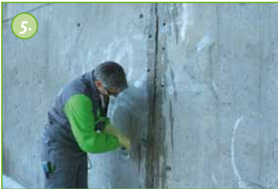
Der Riss wird vorgenässt.
