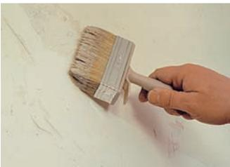
**... werden die Grundierung (ASS® 1) und mindestens 15 Min. später ...**
