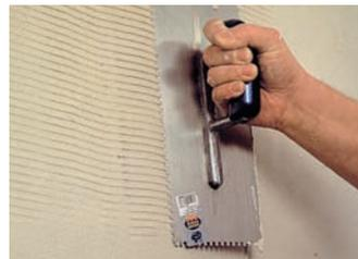
**... wird der Spezialputz (ASS® 3) gleichmäßig dünn aufgetragen ...**
