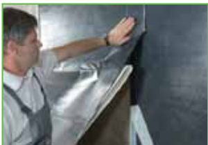
Brtvljenje površine
