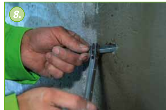
Die Packer werden mit einem Schraubenschlüssel festgezogen.
