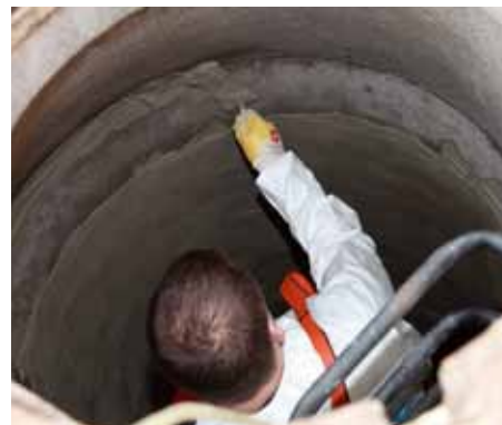
Anschluss des Abwasserschachtes an den Einstiegsbereich
