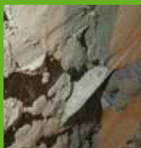
Aufbringen des KÖSTER Sanierputzes
