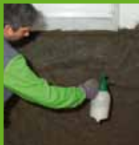
Grundierung mit KÖSTER Polysil® TG 500
