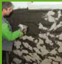
Aufbringung des KÖSTER Spritzbewurfs
