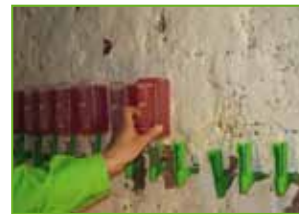
Einsetzen der Kartuschen
