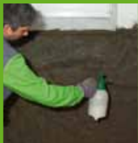
Grundieren mit KÖSTER Polysil® TG 500
