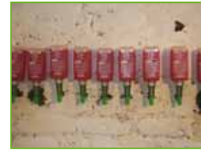
Selbständige Installation der Horizontalsperre
