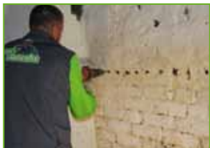
Waagerechte Bohrung in die Lagerfuge
