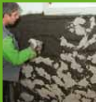
Aufbringen des KÖSTER Spritzbewurfs
