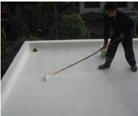
Auftragen der zweiten Lage. Das KÖSTER Armierungsgewebe wird mittig zwischen beide Lagen eingebettet.
