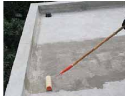
Grundierung mit KÖSTER Polysil® TG 500
