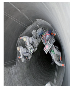
Die Betonschutzarbeiten
