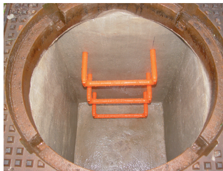
Der instandgesetzte Schacht
