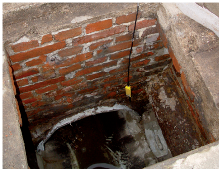
Der unbehandelte Schacht
