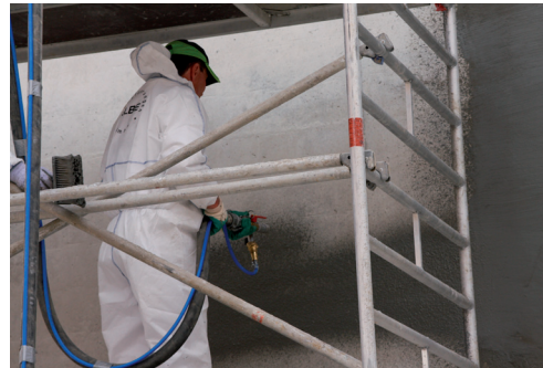
Aufbringen der kristallisierenden Beschichtung
