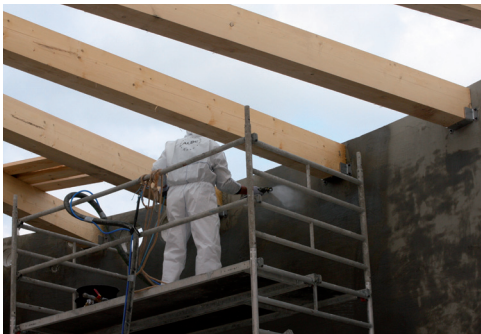
Aufbringen der Schutzbeschichtung
